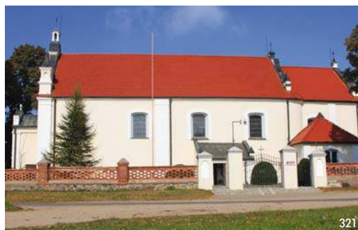
321 Bryła kościoła w Radzyminie nadano obecny kształt w trakcie przebudowy na pocz. XX w.
