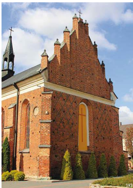
193 Elewacja wschodnia kościoła pw. św. Michała Archanioła ozdobiona geometrycznym motywem z ciemnej cegły tzw. zendrówki. Otwory pomiędzy ceglami powstawały w trakcie budowy – w tych miejscach były osadzone belki rusztowań. Po ukończeniu budowy otwory zostawiano na wypadek konieczności ponownej budowy rusztowań, np. przy remoncie dachu
