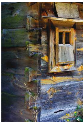
41 Biele. Przykład drewnianej konstrukcji zrębowej
